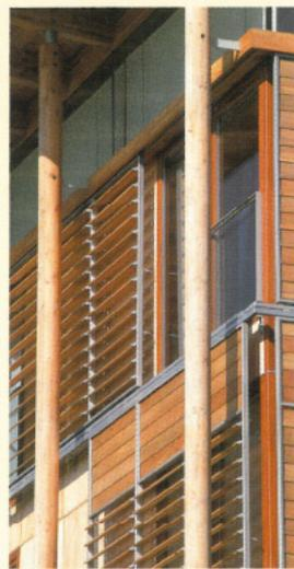
➤ Des volets à lames orientables coulissantes et repliables modulent avec précision l'occultation des baies.
